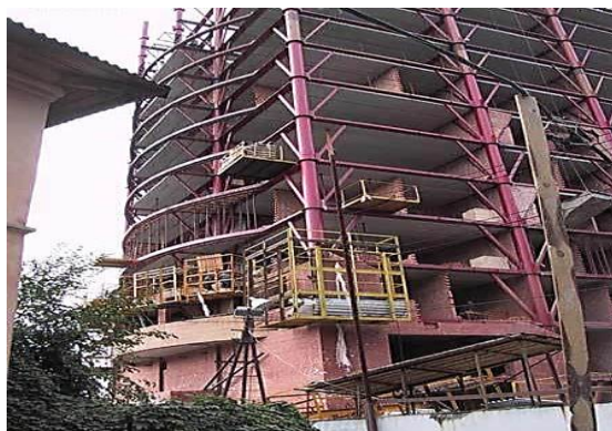
Рис.3.Фрагмент строительства многоэтажного здания с применением в качестве вертикальных несущих конструкций трубобетона Fig.3.Fragment of construction of multi-storey building With the use of as vertical bearing structures of pipe concrete
