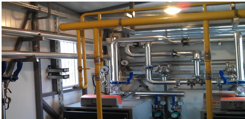
Рис.4. Водогрейные котлы с импульсной циркуляцией теплоносителя Fig. 4. Hot-water boilers with impulse coolant circulation
